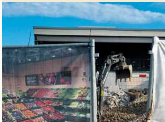
Baustelle Coop © 2024 Sandro Fischer
