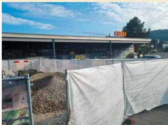
Baustelle Coop © 2024 Sandro Fischer
